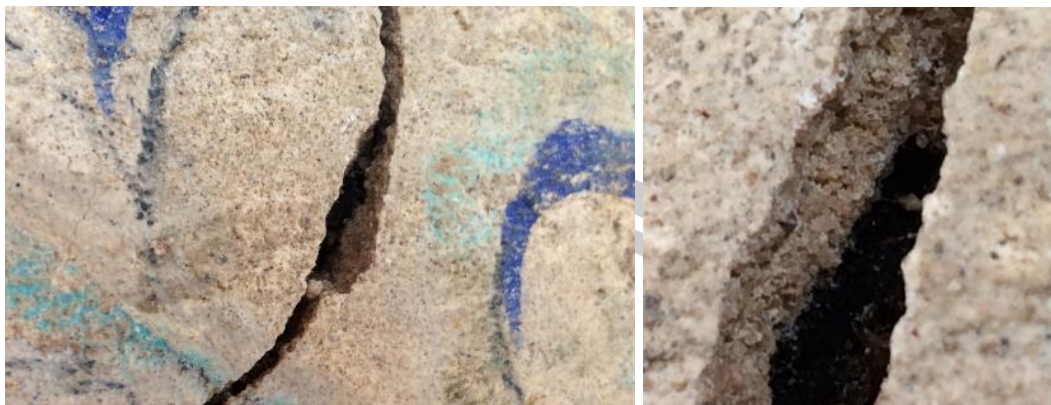
ภาพประกอบ 88 รอยแตกของผนังปูนวัดโพธาราม พบว่าปูนมีเพียงชั้นเดียวไม่มีร่องรอยของน้ำ ซีเมนต์
