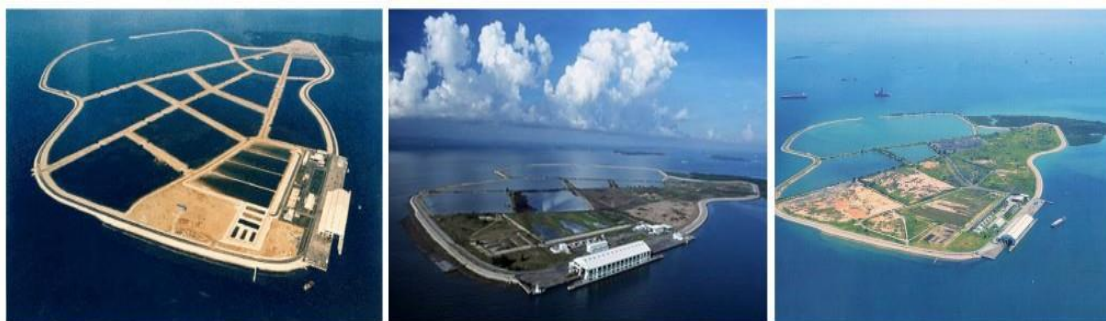
ภาพประกอบ 16 เกาะ Semakau จากปีแรกที่เริ่มก่อสร้าง ค.ศ.1999, 2007 และปัจจุบัน ตามลำดับจากซ้ายไปขวา
