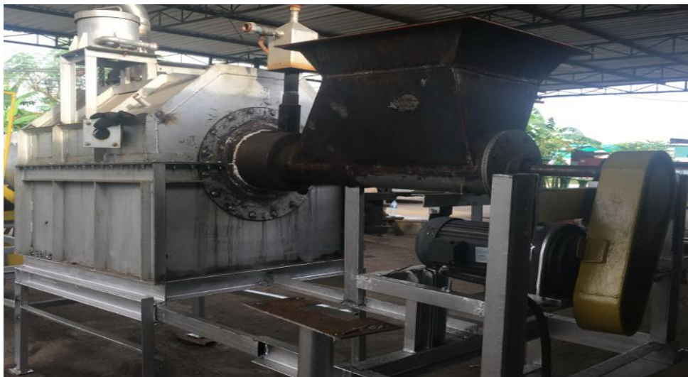
ภาพประกอบ 59 ระบบการป้อนขยะ (Hopper)
