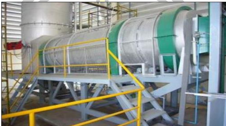
ภาพประกอบ 28 เตาเผาห้องเดียวแบบตะแกรง (Static grate) [11]
