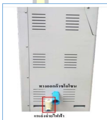
ภาพประกอบ 35 ต่อสายไฟฟ้าเข้ากับแหล่งจ่ายไฟฟ้า
