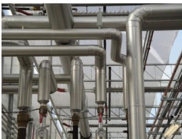
ภาพประกอบ 2.24 ตัวอย่างการหุ้มฉนวนตรงท่อส่งไอน้ำ [3]
