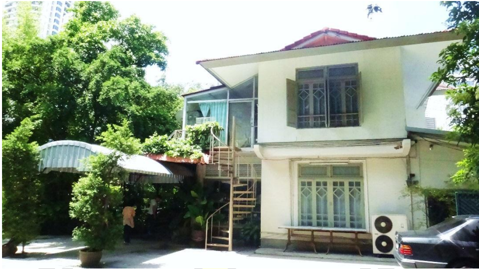
ภาพประกอบที่ 89 บริเวณภายนอกอาคารร้านอาหารท่านหญิง
