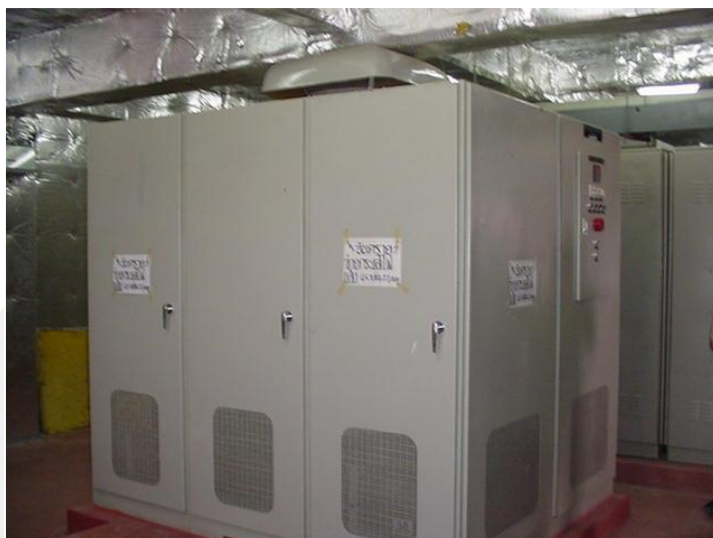
ภาพประกอบ 11 รูปแสดง แบบติดตั้งพัดลมไว้ด้านบน
