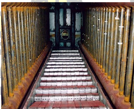
ภาพที่ 18 ภาพถ่ายแสดงให้เห็นตะกรับที่อยู่ด้านในของเตาเผามูลฝอย
