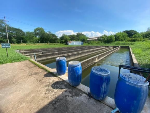
ภาพที่ ข-2 จุดปล่อยน้ำออกจากระบบบำบัดน้ำเสีย
