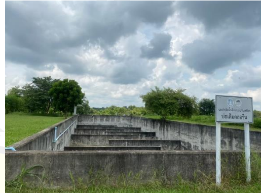
ภาพที่ ข-2 จุดปล่อยน้ำออกจากระบบบำบัดน้ำเสีย
