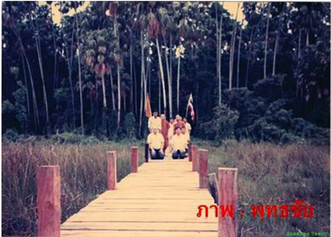
ภาพประกอบที่ 107 สะพานไม้คำชะโนดในอดีต
