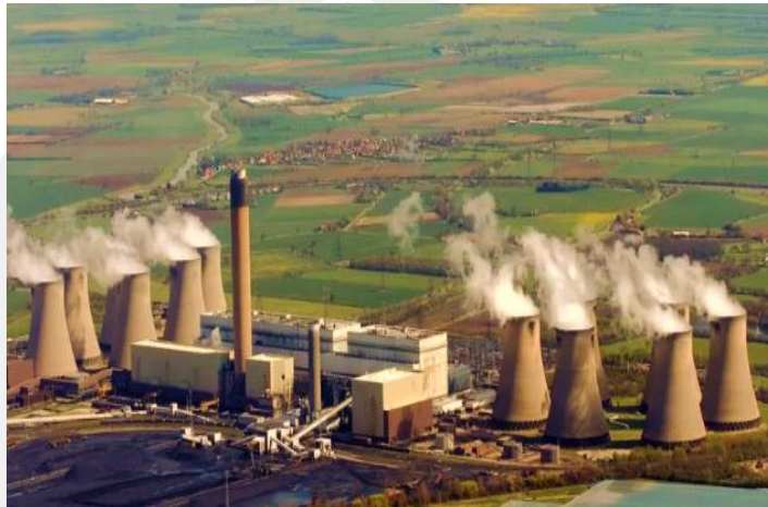
ภาพประกอบที่ 3 โรงไฟฟ้าถ่านหิน
