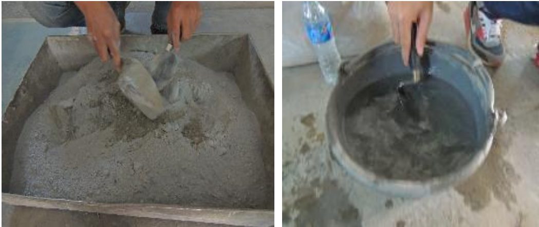
ภาพประกอบ 14 การผสมปูนซีเมนต์กับซิลิกาฟุ่มและผสมน้ำกับสารลดน้ำยิ่งยวด
