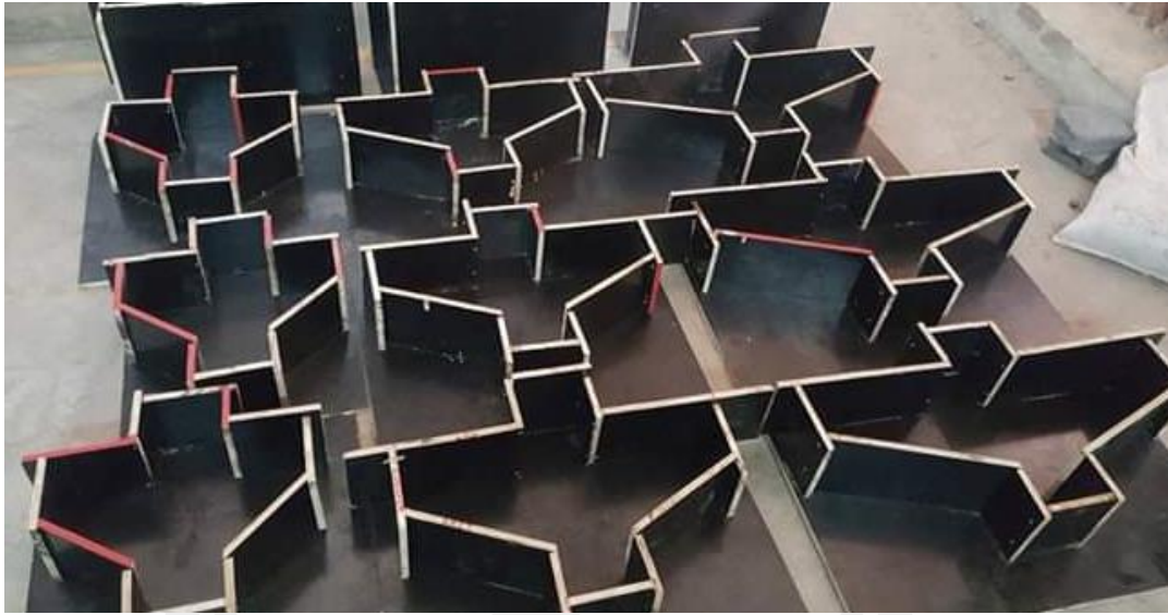
ภาพประกอบ 12 เตรียมแบบหล่อคานหูกข้าง
