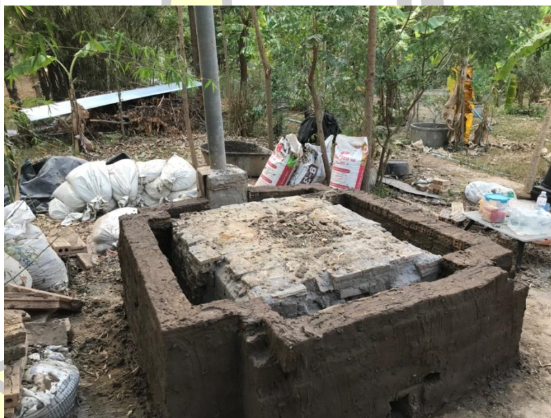
ภาพที่ 25 ภาพแสดงเตาเผาอิฐจำลองที่ใส่ฉนวนกันความร้อน
