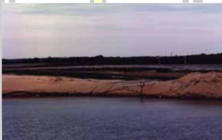
ภาพประกอบ 37 ลักษณะของ Surface Pond ที่ใช้ในการหมุนเวียนน้ำชะขยะ ที่มา : ( http://www.able.co.th : เว็บไซต์)
