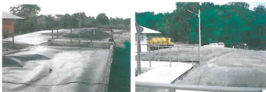
ภาพประกอบ 24 รูปแสดงบ่อหมักไม่ใช้อากาศปิดฝาที่ใช้สร้างก๊าซชีวภาพ
