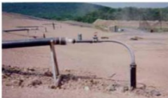
ภาพประกอบ 32 ระบบรวบรวมก๊าซแบบผสมผสาน (Hybrid Collection System)
