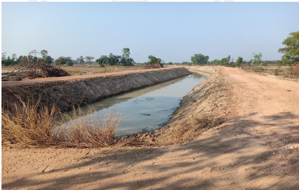
ภาพประกอบ 19 แสดงการก่อสร้างธนาคารน้ำใต้ดินระบบเปิด กรณีแหล่งน้ำสาธารณะ หนองกระต๊อบเหนือ บ้านนากระต๊อบ ตำบลท่าม่วง อำเภอเสลภูมิ จังหวัดร้อยเอ็ด ที่มา : เทศบาลตำบลท่าม่วง อำเภอเสลภูมิ จังหวัดร้อยเอ็ด (2562)
