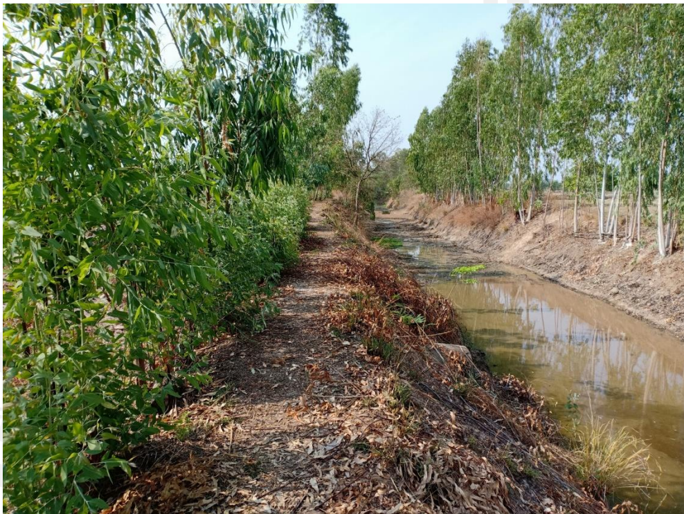
ภาพประกอบ 17 แสดงการก่อสร้างธนาคารน้ำใต้ดินระบบเปิด กรณีแหล่งน้ำสาธารณะ หนองกระต๊อบเหนือ บ้านนากระต๊อบ ตำบลท่าม่วง อำเภอเสลภูมิ จังหวัดร้อยเอ็ด ที่มา : เทศบาลตำบลท่าม่วง อำเภอเสลภูมิ จังหวัดร้อยเอ็ด (2562)
