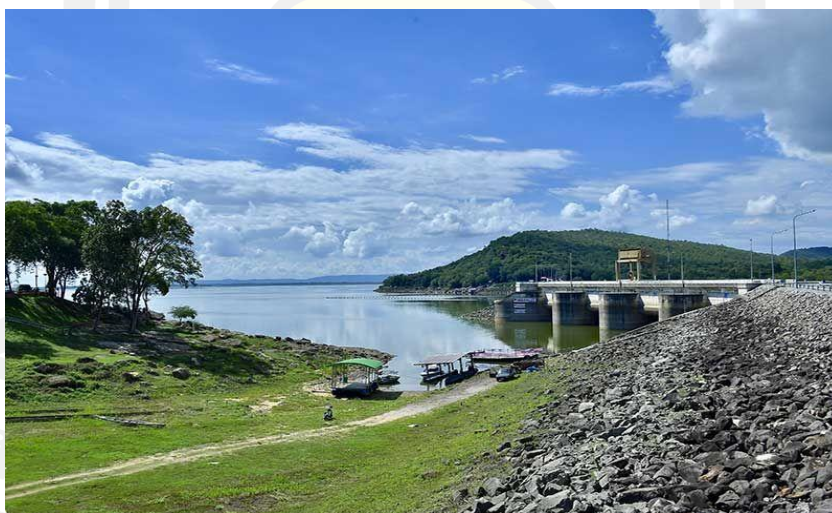
ภาพประกอบ 38 เขื่อนอุบลรัตน์ จังหวัดขอนแก่น
