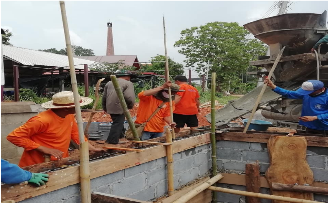
ภาพการให้ความช่วยเหลือพระสงฆ์ของพนักงานท้องถิ่น เทปูนทำทางระบายน้ำ
