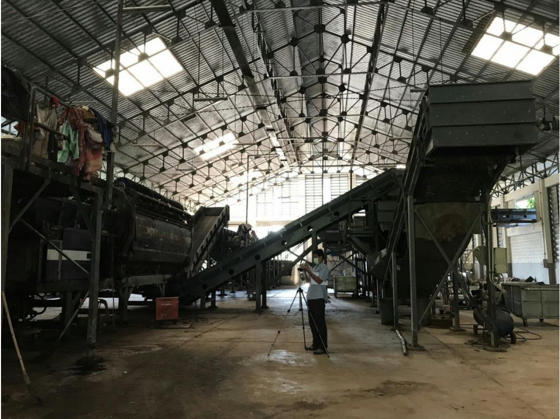
ติดตั้งเครื่องเก็บตัวอย่างอากาศ
