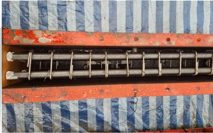
ภาพประกอบ 21 การเข้าแบบเสาคอนกรีตสมรรถนะสูง
