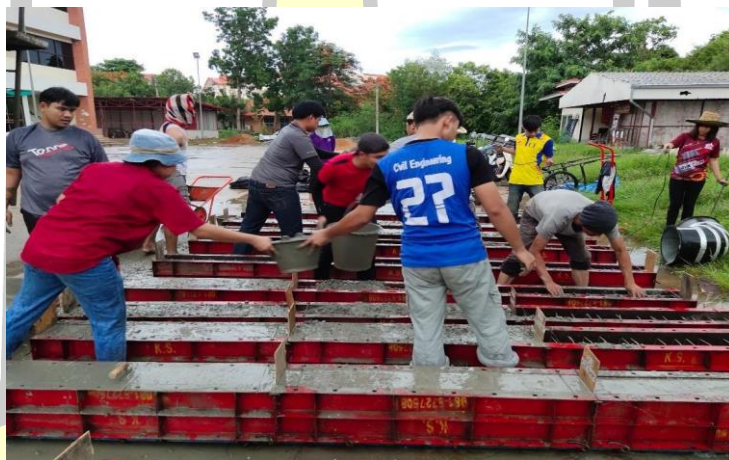
ภาพประกอบ 22 การเทเสาคอนกรีต
