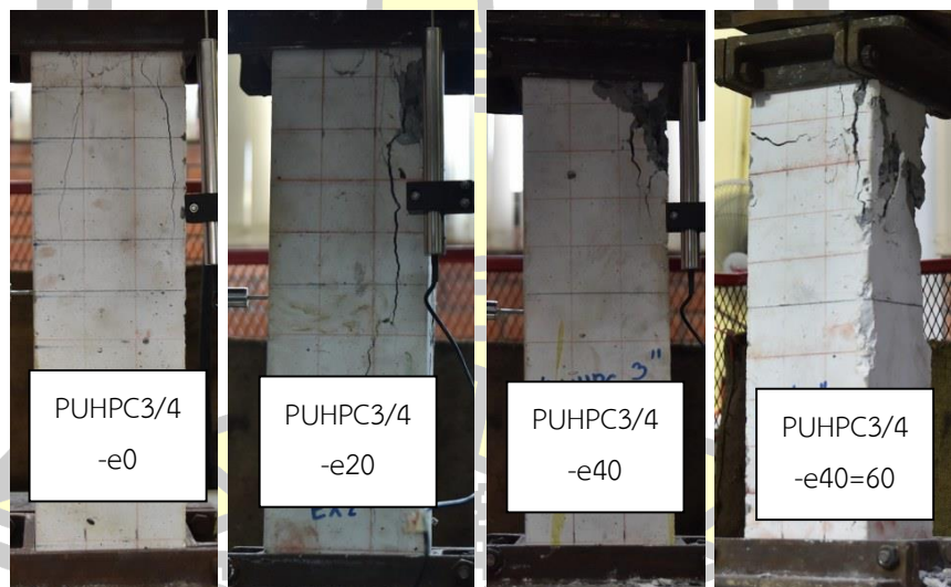
ภาพประกอบ 51 ภาพการวิบัติของเสาคอนกรีตเสริมท่อเหล็กสำเร็จรูปบรรจุ UHPC ขนาด 3/4 นิ้ว (PUHPC3/4) ในแนวแกนและที่ระยะเยื้องศูนย์กลางต่างๆ
