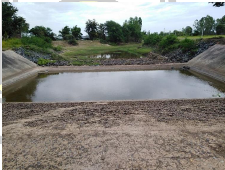
ภาพที่ 63 ฝายคอนกรีตบ้านยานาง
