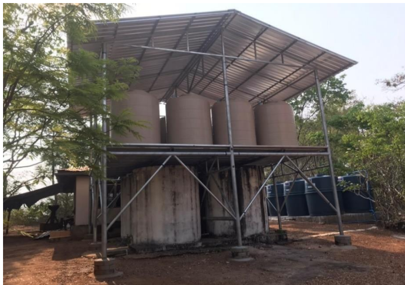
ภาพประกอบที่ 51 ภาพรวมระบบเก็บกักน้ำฝนและน้ำบาดาลวัดถ้ำเสี่ยงของ ภาพโดย ผู้วิจัย (2566)
