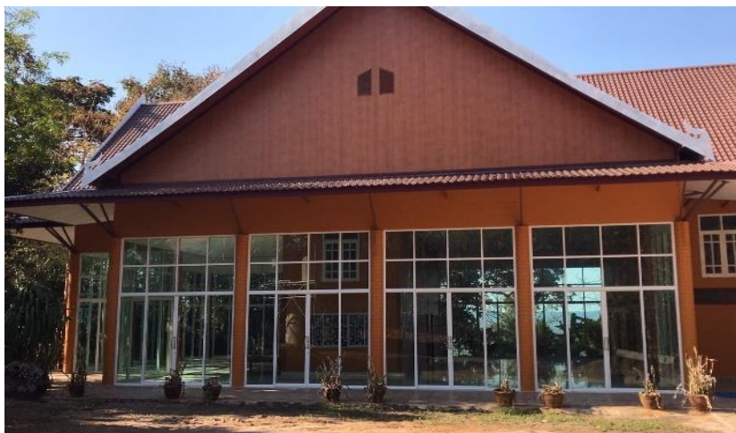
ภาพประกอบที่ 37 ด้านหน้าศาลาเอนกประสงค์หลังใหม่ สร้าง พ.ศ. 2562-2565 (แทนหลังใหม่)
