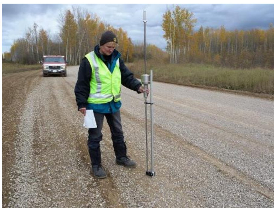
ภาพประกอบ 2.23 การทดสอบ Dynamic Cone Penetration Test บนถนนสายหนึ่ง ที่มา ( http://westcoastroadtesting.com )
