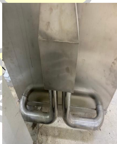
ภาพที่ 35 ระบบหมุนเวียนอากาศท่อลมขนาด 75 mm วัสดุสแตนเลสเกรด 304 (SUS 304) 2 ชุด
