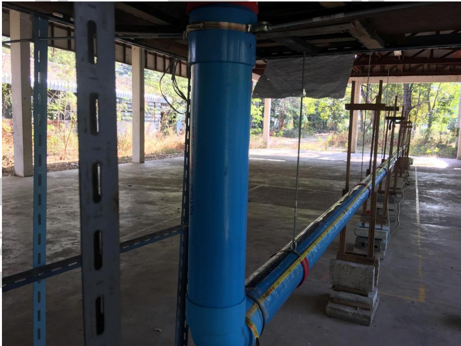
ภาพประกอบที่ 43 การติดตั้งท่อพีวีซีที่หุ้มด้วยแผ่นพีวีซีใส
