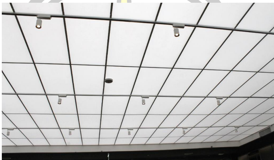
ภาพประกอบ 117 เพดานที่ใช้แสงสว่างจากภายนอกอาคาร
