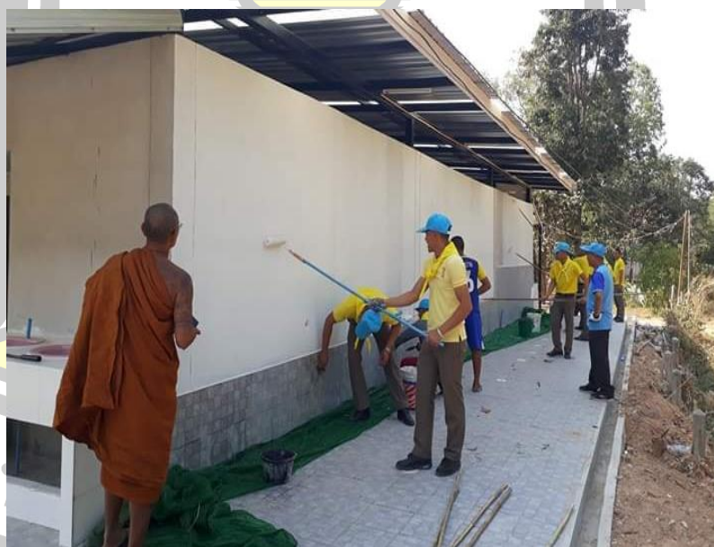
ภาพที่ 116 การสร้างห้องน้ำในโรงเรียนชุมชนบ้านโนนทอง
