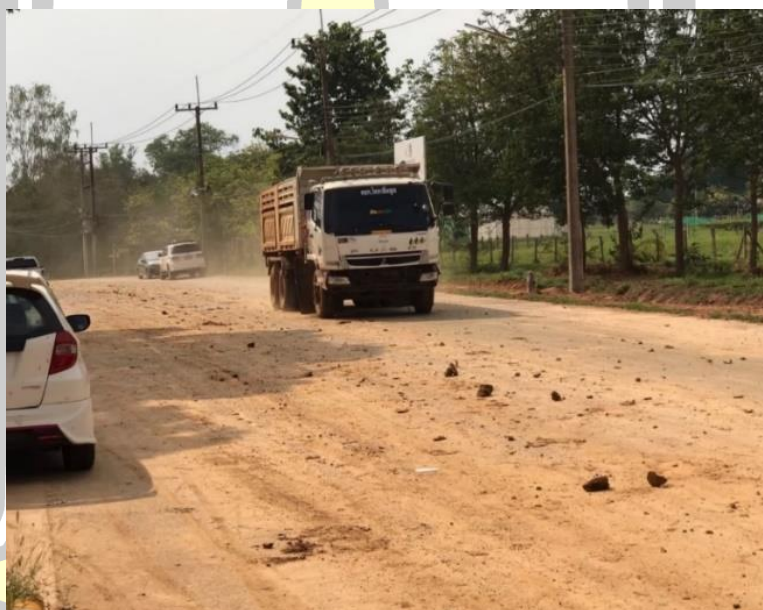
ภาพประกอบ 49 ฝุ่นละอองจากดินอันเนื่องมาจากการขนส่งในกระบวนการก่อสร้าง
