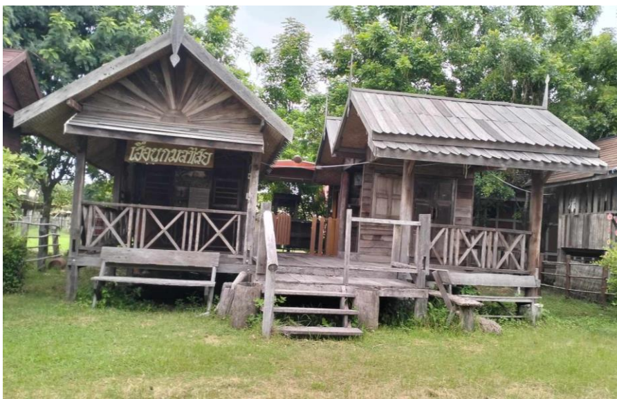
ภาพประกอบ 9 เรือนไม้อีสานโบราณ
