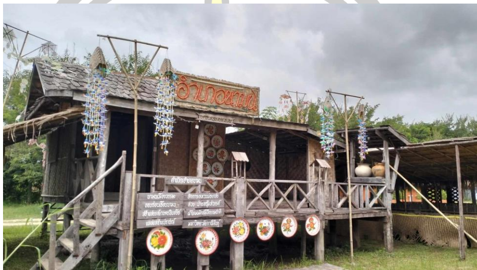
ภาพประกอบ 6 เรือนไม้อีสานโบราณ
