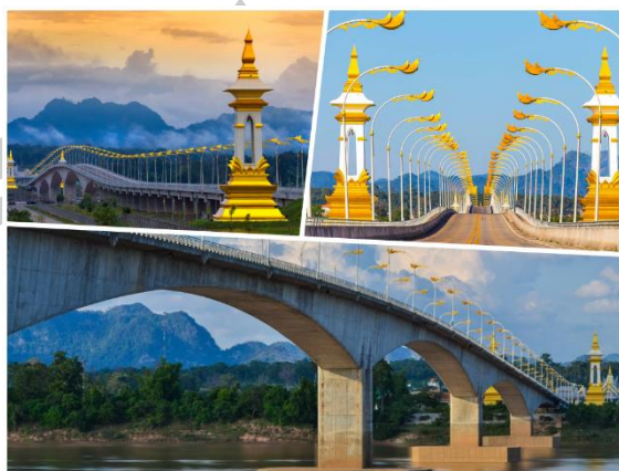
ภาพประกอบ 1 สะพานมิตรภาพไทย-ลาว แห่งที่ 3 จังหวัดนครพนม (ที่มา : https://www.checkinchill.com )
