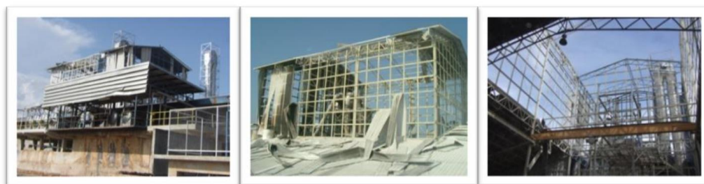
ภาพที่ 8 แสดงอาคารโรงงาน บริเวณไซโคลนเย็น และห้องบรรจุแบ่งเสียหายจากการระเบิด ที่มา: กรมโรงงานอุตสาหกรรม (2553)
