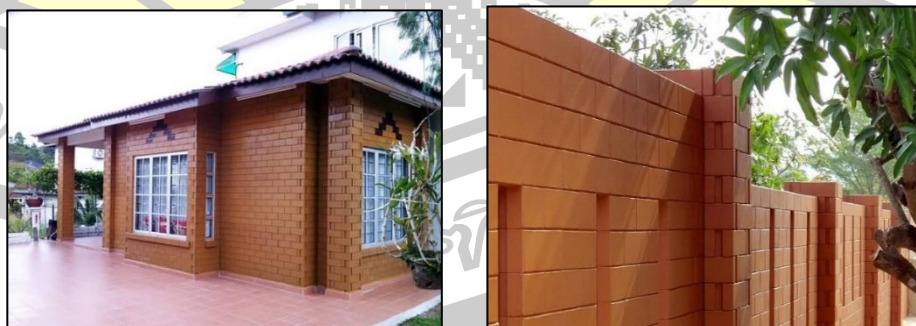
ภาพประกอบ 8 การนำอิฐบล็อกประสานไปใช้งาน
