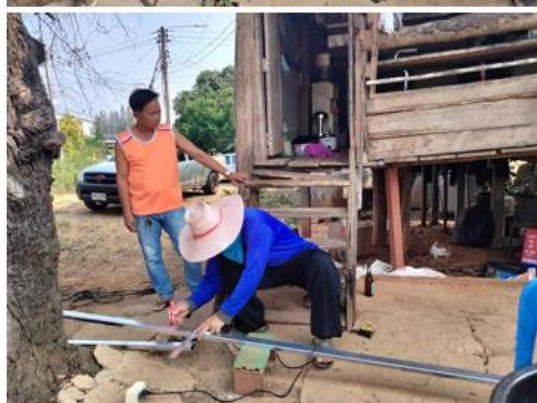
บ้านผู้สูงอายุที่ได้รับการปรับปรุงที่จับเดินบันได ให้มีความแข็งแรงขึ้น
