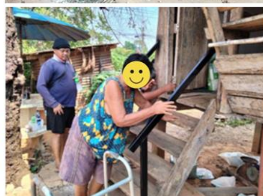
บ้านผู้สูงอายุที่ได้รับการปรับปรุงที่จับเดินบันได ให้มีความแข็งแรงขึ้น
