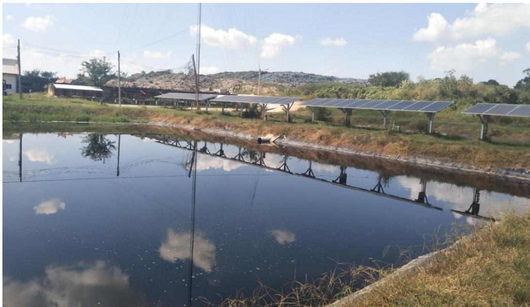
ภาพประกอบ 10 บ่อรวมน้ำชะขยะเทศบาลเมืองมหาสารคาม
