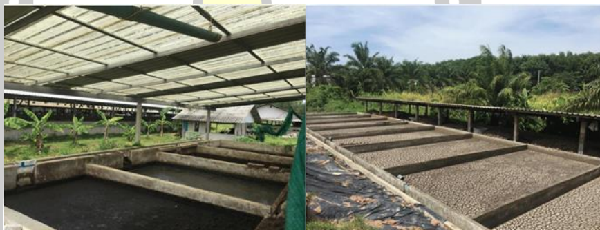
รูปที่ 5 ลานตากตะกอนแบบที่มีหลังคาและไม่มีหลังคา
