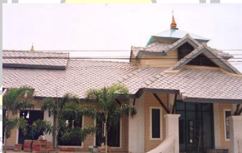
ภาพประกอบ 2.2 อาคารที่มุงกระเบื้องหลังคาซีเมนต์ [29]
