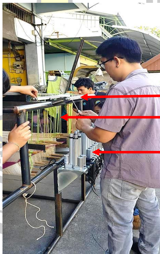
ภาพประกอบ 57 การติดตั้งระบบกลไก
