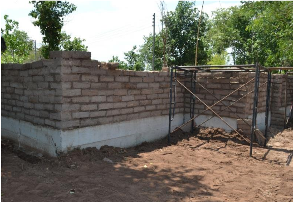
ภาพประกอบ 67 การเทคานคอนกรีตกันปลวกอาคารอเนกประสงค์ มหาวิทยาลัยกาฬสินธุ์
