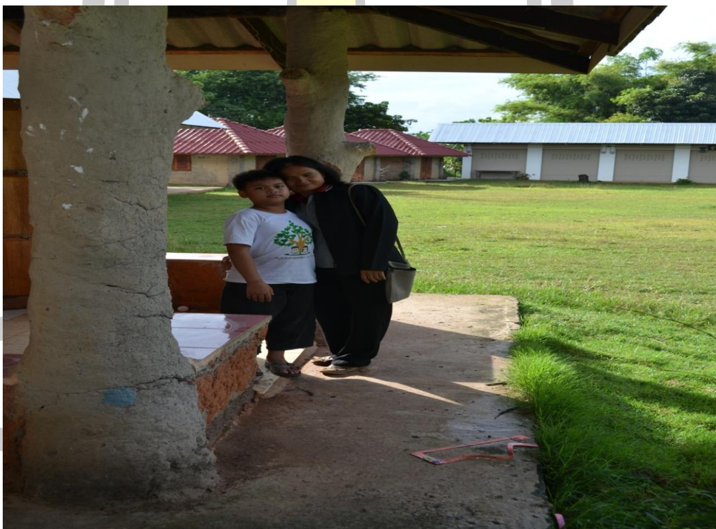
ภาพประกอบ 35 เสาสเสริมบ้านดินบ้านศรีฐาน จังหวัดยโสธร
