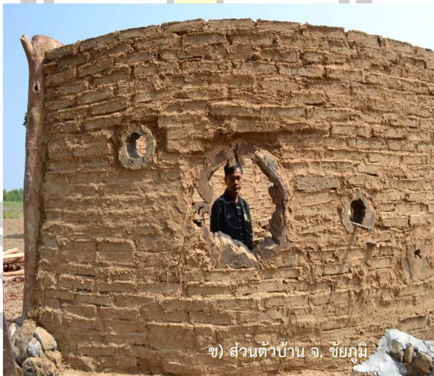
ภาพประกอบ 40 ผนังดินช่องอากาศ บ้านดินสายรุ้ง จังหวัดชัยภูมิ
