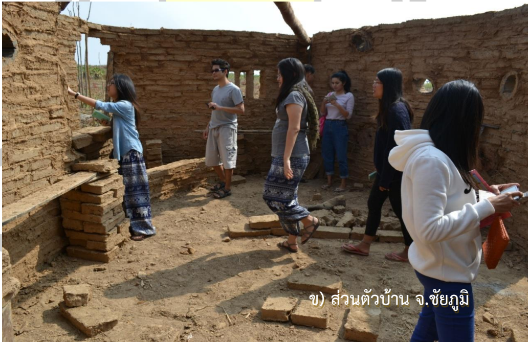
ภาพประกอบ 38 การก่อผนังดิน บ้านดินสายรุ้ง จังหวัดชัยภูมิ
