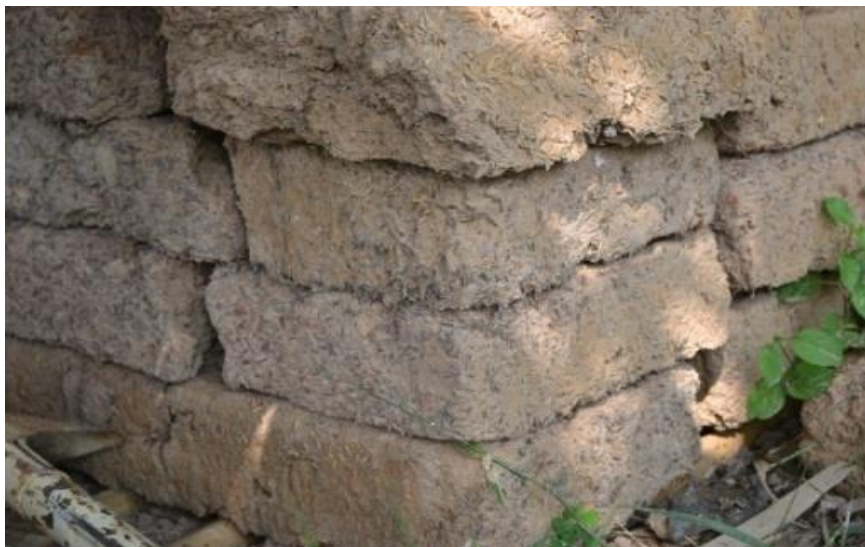
ภาพประกอบ 5 การจัดเก็บก้อนอิฐดินดิบรอการก่อสร้าง
