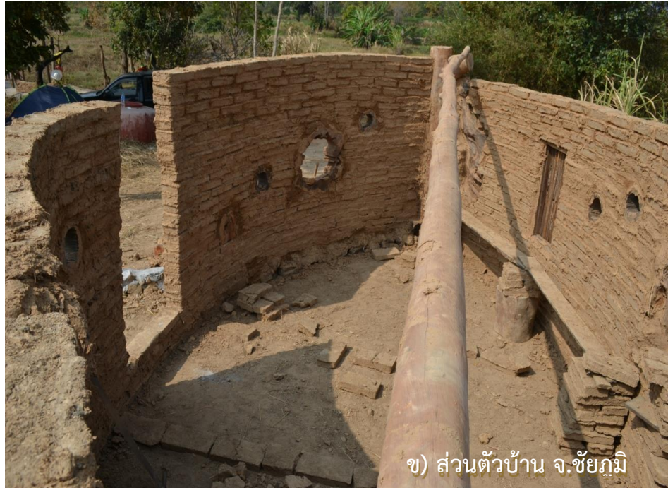
ภาพประกอบ 39 การก่อผนังดิน บ้านดินสายรุ้ง จังหวัดชัยภูมิ
