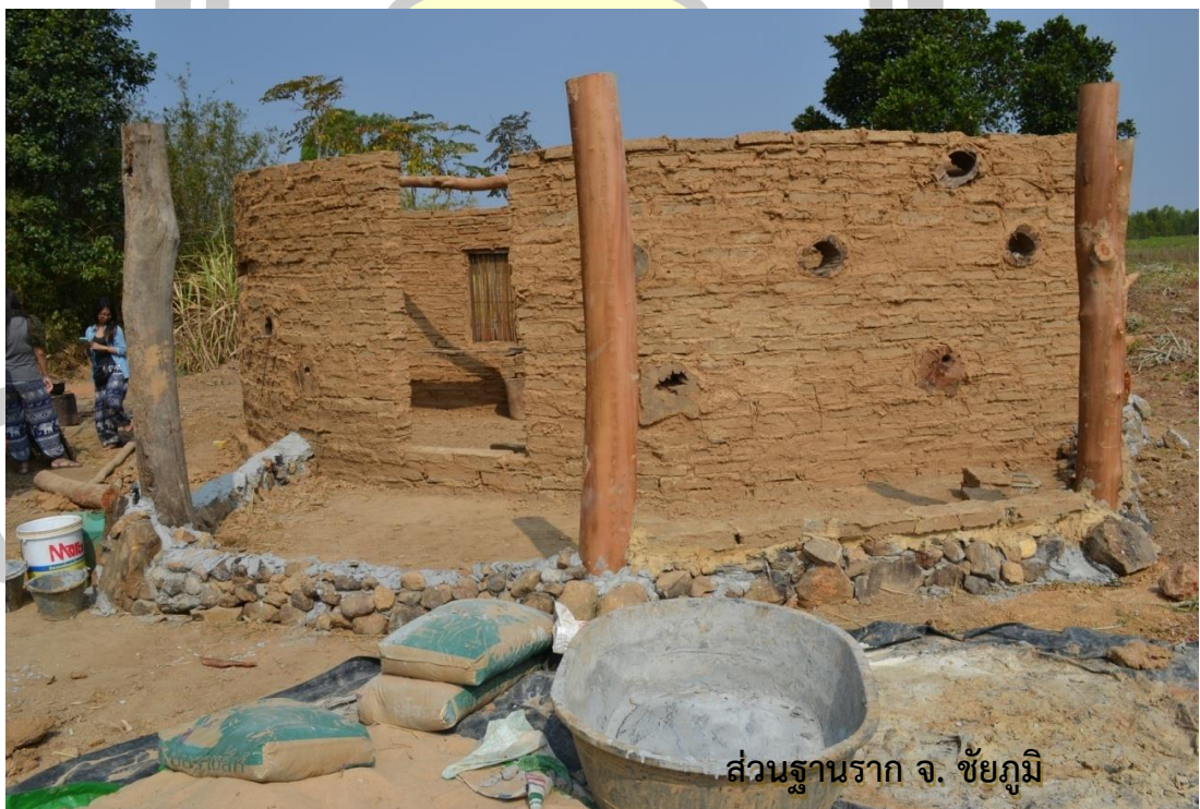
ภาพประกอบ 31 การก่อผนังดินแบบไม่มีคานของบ้านดินสายรุ้ง จังหวัดชัยภูมิ
