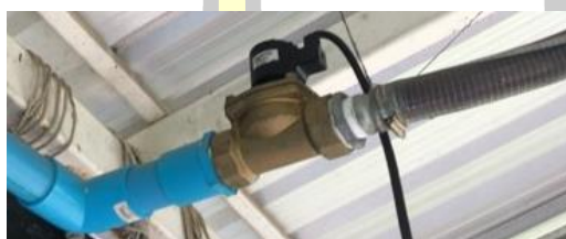
ภาพประกอบ 4.3 โซลินอยด์วาล์ว แบบ 2/2 ทาง
