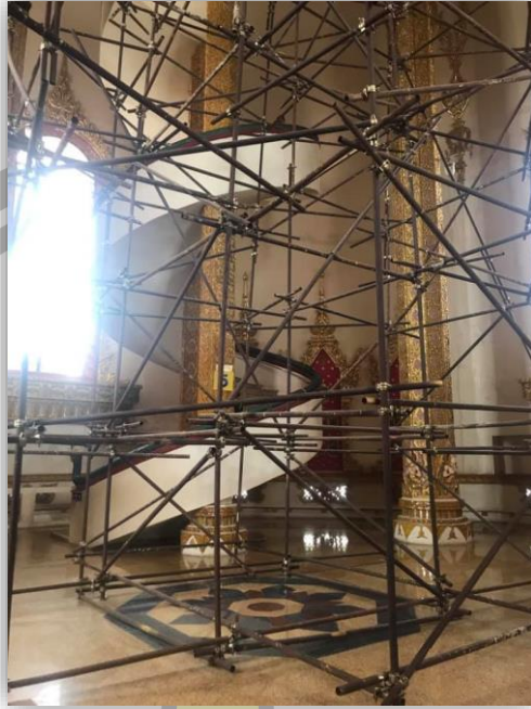
ภาพประกอบ 32 การก่อสร้างภายในอาคาร พระมหาเจดีย์ชัยมงคล
