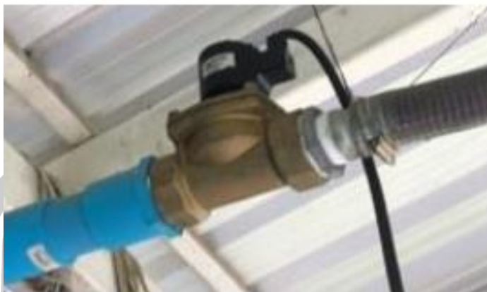
ภาพประกอบที่ 21 โซลินอยด์วาล์ว ชนิด 2”/2 ทาง
