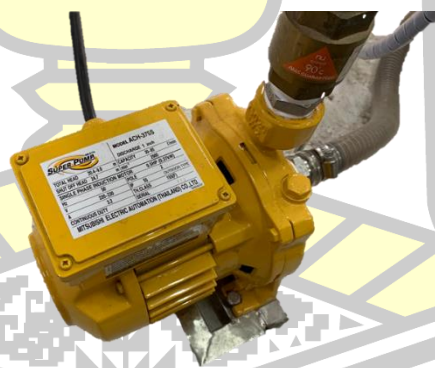
ภาพประกอบที่ 39 ป้อนน้ำชนิดหอยโข่งขนาด 0.5 แรงม้า
