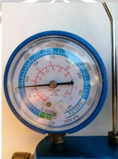
ภาพประกอบ 34 สารทำความเย็นในระบบเท่ากับ 80 psi
